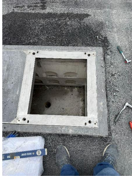
2. M20-Schrauben fetten und anschliessend leicht im Gewinde ansetzen
