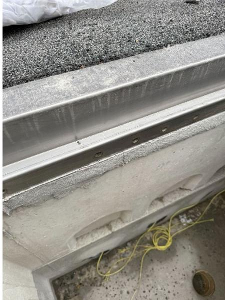
2. Muttergehäuse (Konsole) mit dem T-Blech verschrauben (2x M12x25 V2A)
