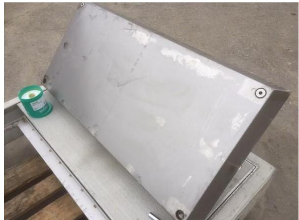
Zum Schluss wird der Deckel dann wieder umgedreht und 2 Regulierungen auf der langen Seite sind auch von oben sichtbar. Nun kann mit dem 12-er Inbus die Regulierungsschraube so eingestellt werden bis der Deckel nicht mehr wackelt. Sobald die Einstellung klapperfrei ist wird mit der Kontermutter (14 er Schlüssel) die Einstellung gesichert. Zum Schluss werden noch die Kunststoffpfropfen mindestens auf die Schlüsselstücke mit Regulierung gesetzt um Verunreinigung zu vermeiden.
