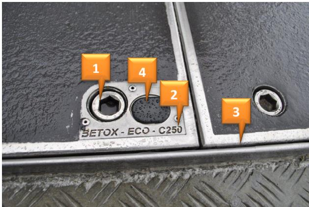
Abdeckungen haben rundherum ca. 1 mm Spiel (3) damit diese jederzeit geöffnet werden können. Deshalb ist dieser Typ nicht wasserdicht. Je nach Grösse und Belastungsklasse (2) sind die Deckel verschraubt. Alle Belastungsklassen über B125 sind standardmässig aus Sicherheitsgründen an allen 4 Ecken verschraubt (1). Die Verschraubung kann mit einem 17 mm Inbusschlüssel geöffnet werden. Zu beachten dabei ist, dass die **Gewinde jeweils sauber gehalten und eingefettet**
